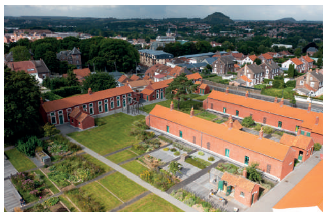
Cité des électriciens © Les Coflocs
